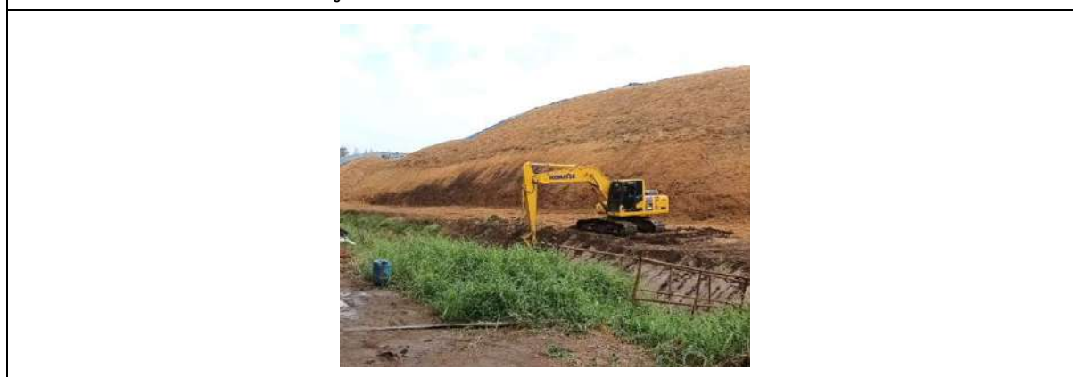
รูปที่ 2-12 การทำความสะอาดร่องระบายน้ำรอบกองขนถ่าย
