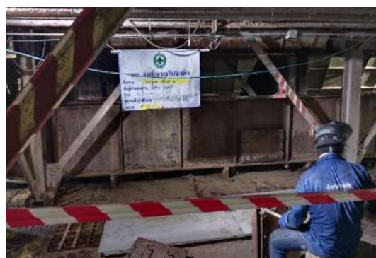
รูปที่ 2-59 การกั้นขอบเขตพื้นที่ก่อสร้าง และป้ายแสดงพื้นที่ก่อสร้าง
