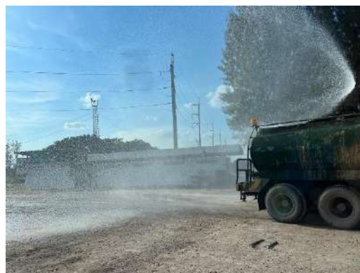
รูปที่ 2-31 การนำน้ำที่ผ่านการบำบัดแล้วมาใช้ในโครงการ
