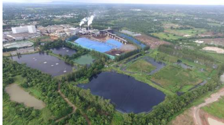
รูปที่ 2-30 ระบบบำบัดน้ำเสียของโครงการ ขนาด 1,800 ลูกบาศก์เมตร/วัน
